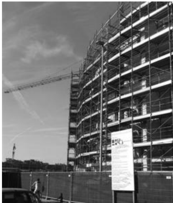
Uno dei colossi in costruzione, con idromassaggio e teleriscaldamento
